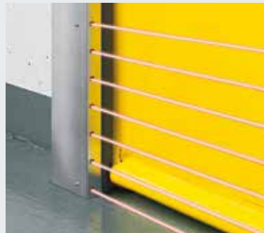
V 2012 Lichtgitter verdeckt in der Torführung
